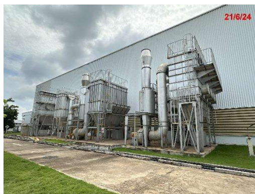
ภาพที่ 2-1 การติดตั้งอุปกรณ์บำบัดมลพิษทางอากาศ
