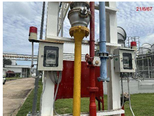
ภาพที่ 2-29 การติดตั้งระบบตรวจจัดการรั่วไหลของก๊าซ
