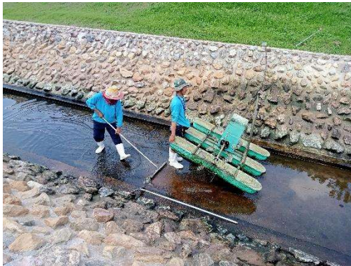
ภาพที่ 2-34 การล้างทำความสะอาดท่อระบายน้ำ และ Recycle Pond
